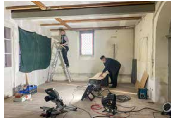
Bauarbeiten in der Göttiner Kirche, Foto: Steffen
