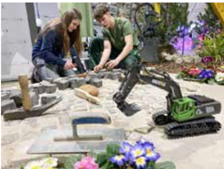
Verlegen eines Pflasterstreifens bei den Gärtnern
